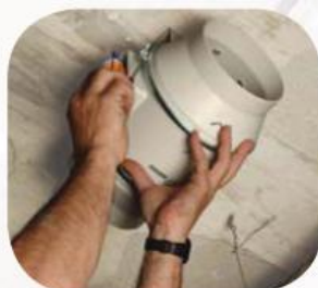
Установите блок двигатель-крыльчатка
