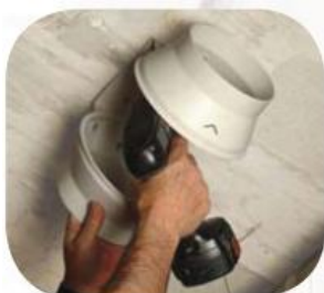
Закрепите основание вентилятора
